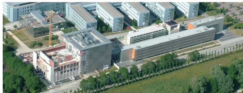
Der Erweiterungsbau des LRZ am Campus Garching für den neuen Hochleistungsrechner SuperMUC
